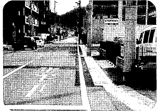
旧国道250号線工事完了
